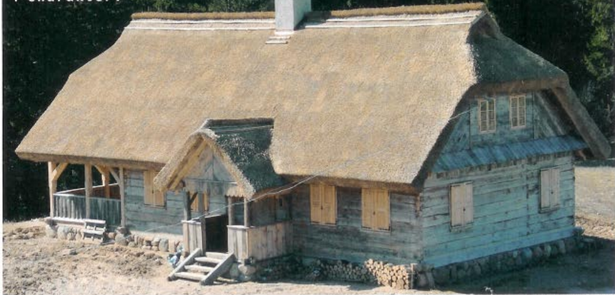
Stary drewniany dom z bali został przeniesiony na nowe miejsce i zmodernizowany
