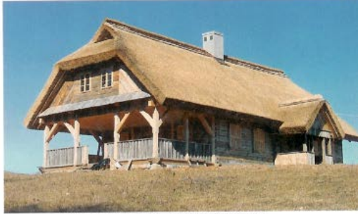
Dom powiększono – zagospodarowano poddasze i dobudowano duży taras
